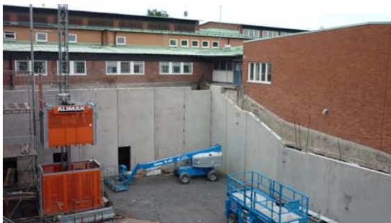
Soprumsväggarna och trappväggarna
