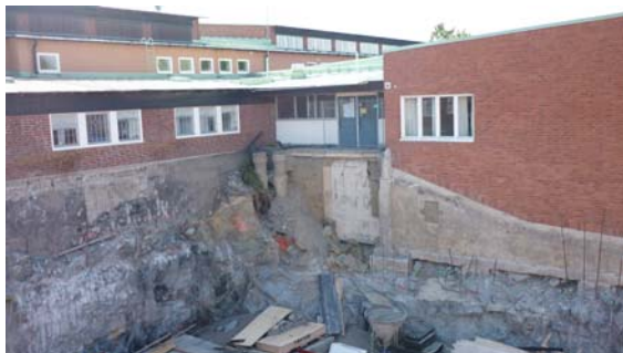
Befintliga hus mot bygget
