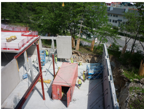
Montage av prefabricerat betongelement
