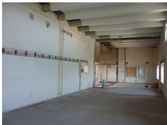
Gamla biblioteket efter att entresolen rivits
