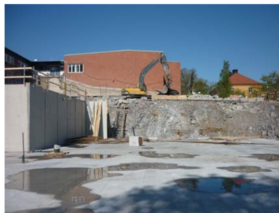
Arbeten med grunden
