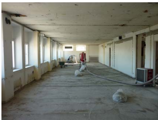
Kontorsrum entréplan efter rivning
