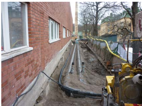
Befintlig fjärrvärme som ska läggas om
