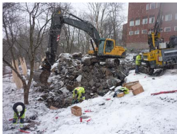
Teleskopgrävare och borr
