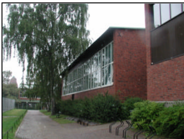
En av idrottshallarna. Den bortre har fått behålla sitt ursprungliga fönsterparti, medan idrottshallen i förgrunden har fått ett nytt fönsterparti på 1980-talet.
